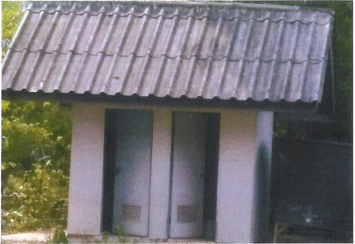
ห้องน้ำสาธารณะบริเวณหนองบัวทอง
